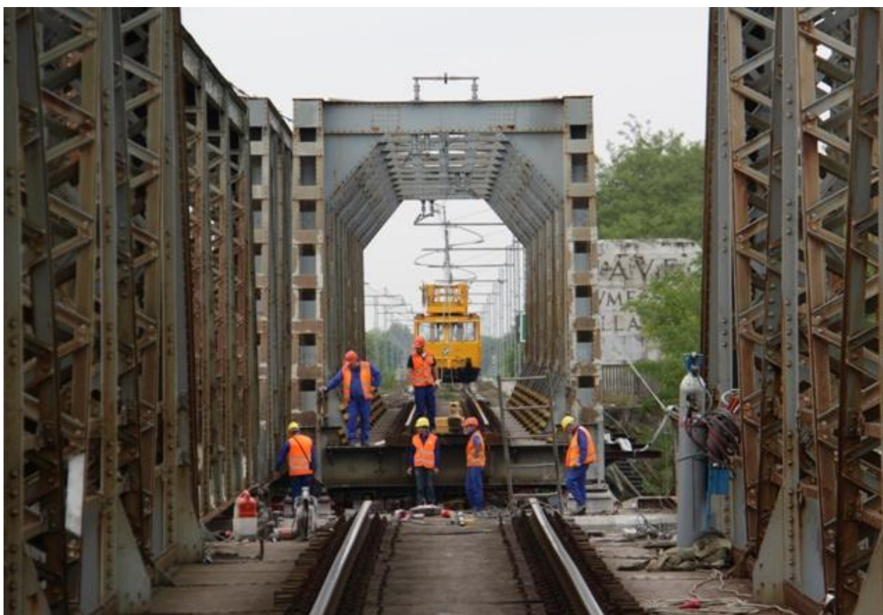
16 Settembre 2012: Sostituzione della trave metallica sul ponte del fiume Piave
